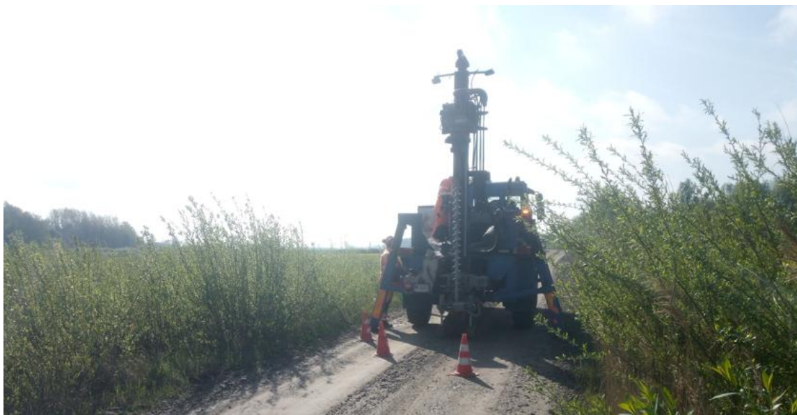
1 pav. Lauko darbai
